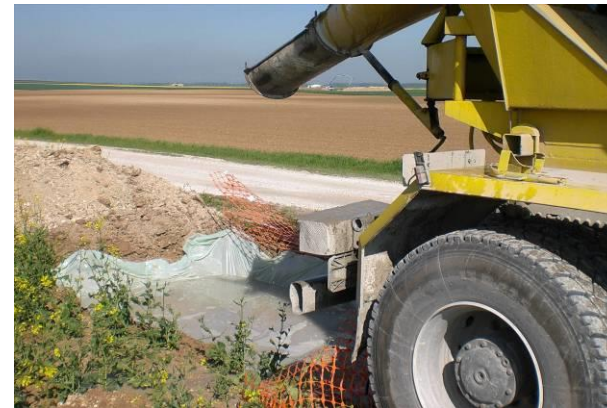
Photo 76 : Exemple de récupération des laitances de béton (Source : BE Jacquel et Chatillon)
